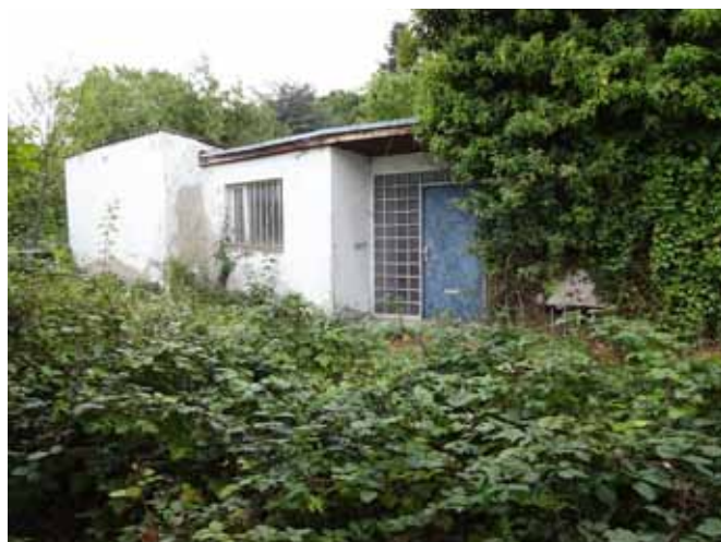
Wohnhaus Leistikow, Zustand Okt. 2015
