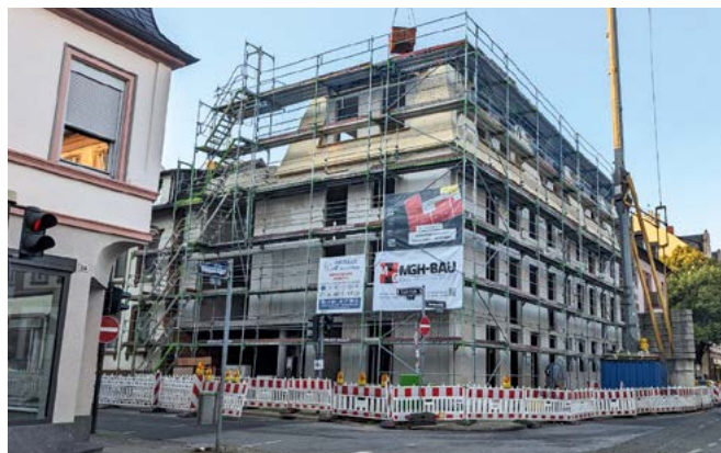
Die Baustelle in der Bolongarstraße 112 (Foto: Sonara eG)
