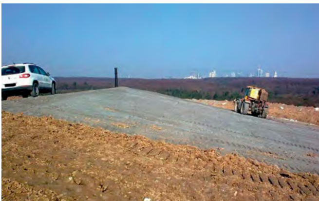
Blick auf die Frankfurter Skyline während der Baumaßnahme für die Oberflächenabdichtung (Foto: Andreas Müller)
